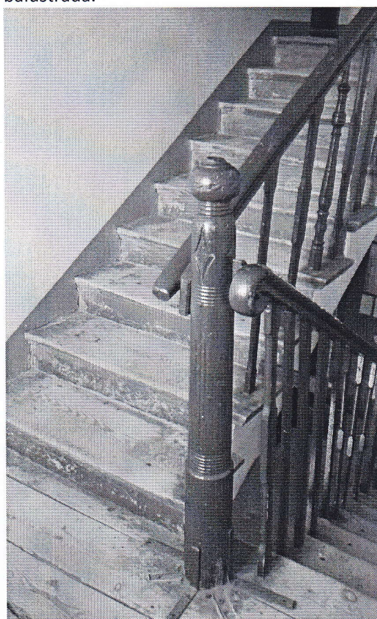
Fot. 3 – Bieg schodowy – widoczna zużyta okładzina drewniana schodów oraz uszkodzona balustrada.
